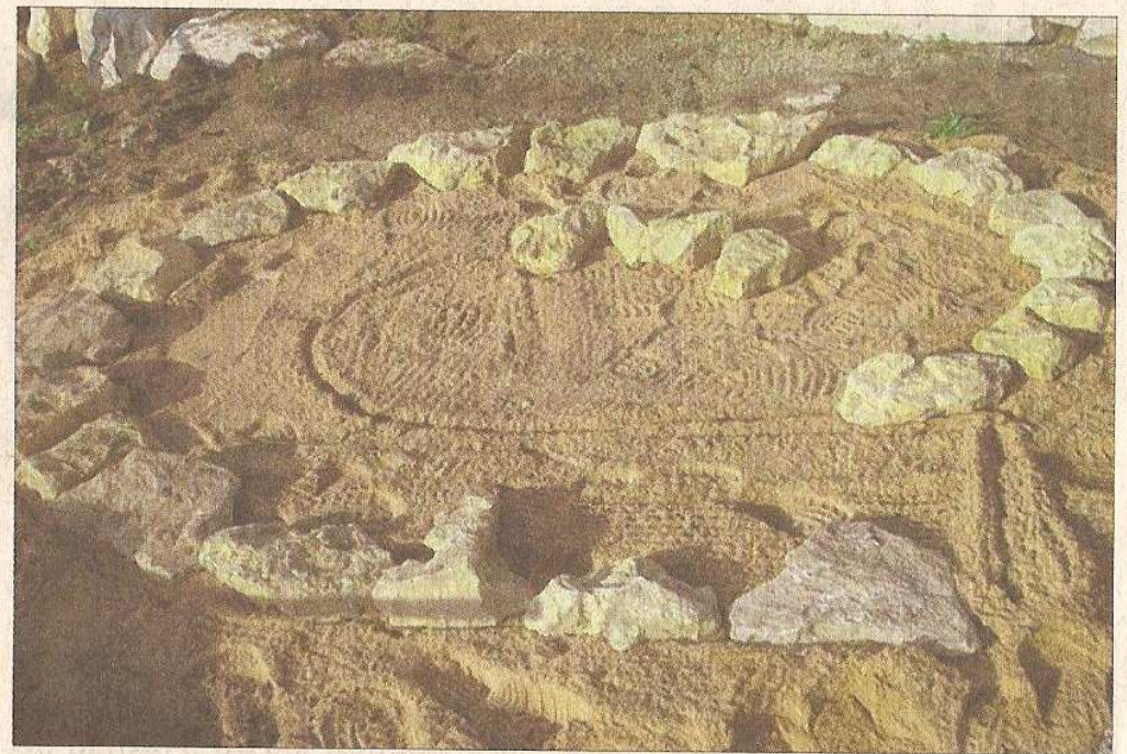
Natursteine werden in Form einer Schnecke aufgelegt. Der Trick: Die nächsten Stein-schichten müssen leicht nach innen geneigt sein – so bleibt die Mauer stabil.
